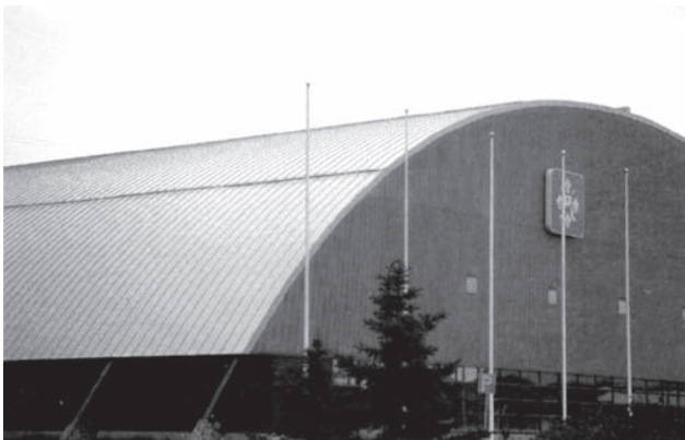
Ilguose šlaituose įrengiami temperatūriniai užlankai.
