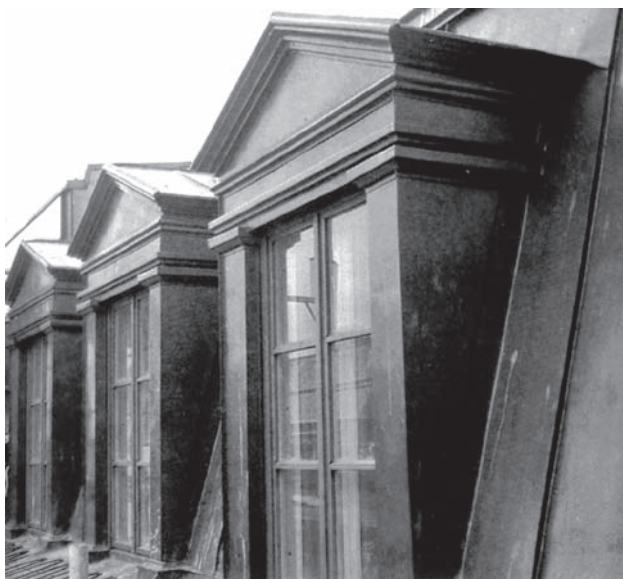
Stogo skardos sujungimas su apskardinta langų dalimi, kur yra įvairių detalių.
