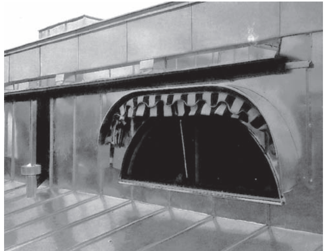
Su skardiniu stogu susijungianti siena ir apskardinta lentjuostė ant jos viršutinio krašto.
