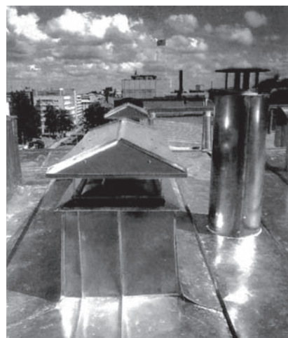
Visiškai apskardintas kaminas. Praeinamasis kūgis sujungtas su šlaito lakštu, užlankai užsandarinti.
