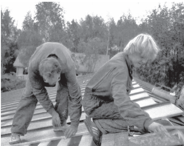
Skardos lakštų pritvirtinimas juostomis.
