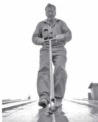
Mechanizuotas stačiojo užlanko užlenkimas.
