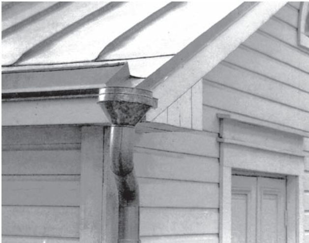
Įlaja su lietvamzdžiu vandens užtvaro ir šoninės nuosvyros susijungimo vietoje.
