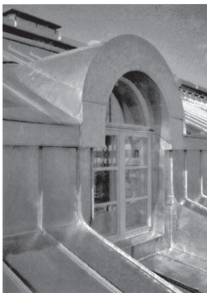
Lenktų pastato dalių apskardinimas. Lenkto paviršiaus jungtis su lygiu paviršiumi įrengta iš skardos gabalų.
