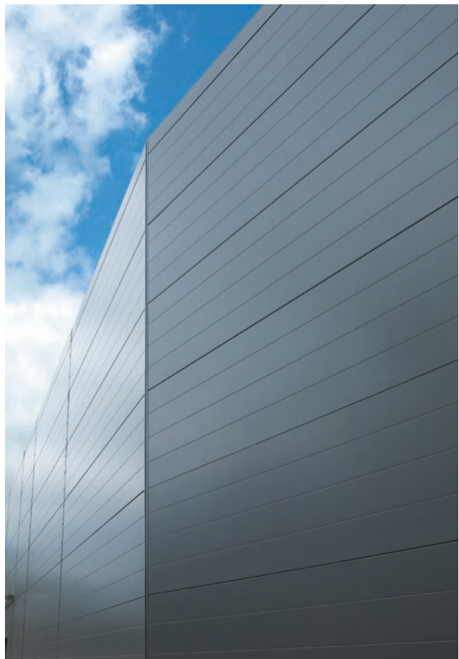
Fasadas iš plokščių su išilginėmis vagelėmis kas 250 mm
